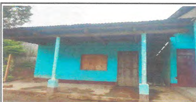
Foto 5: Ampliación de la cocina
