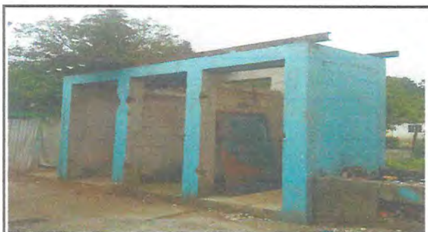
Foto 5: Techo y puertas del segundo módulo de baños
