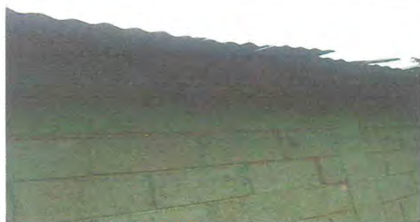
Foto 3: Techo de la cocina la parte de atrás
