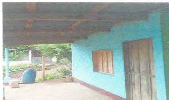
Foto 1: Vigas del techo del corredor de la cocina
